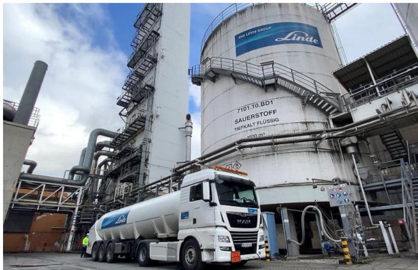
Abbildung 2.4: Oberirdischer Tank zur Speicherung von Flüssigsauerstoff [31]
